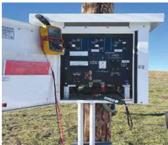
Pipeline rectifier.
